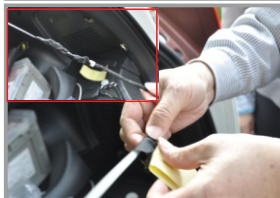
52. Используйте изоленту для защиты проводов
